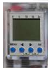
Unidad base de control termostático con salida para control de bomba y caldera.
